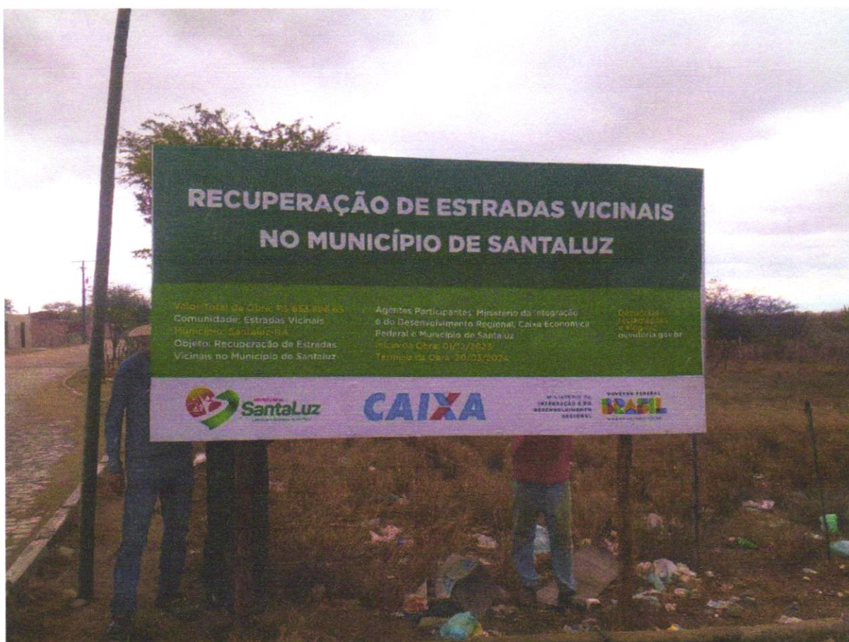
Foto 01 - Placa de obra em chapa aço galvanizado, instalada - Rev 02_01/2022
